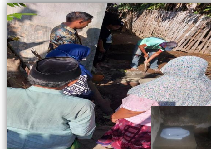
Pembangunan Jamban Keluarga
